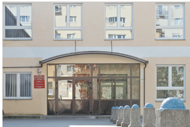
ZSE Nr 2 w budynku przy ul. Świt 25, 2011 rok
